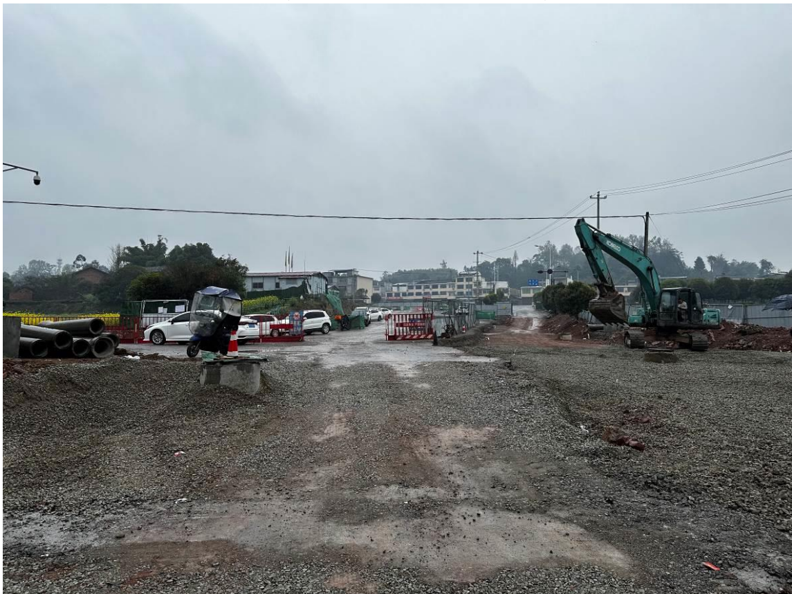
项目区现状路基区域情况（图中为 K0+200 向起点方向拍摄）
