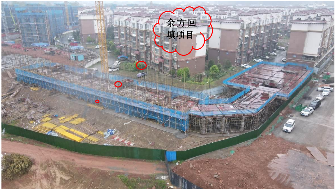
余方回填利用项目现状情况
