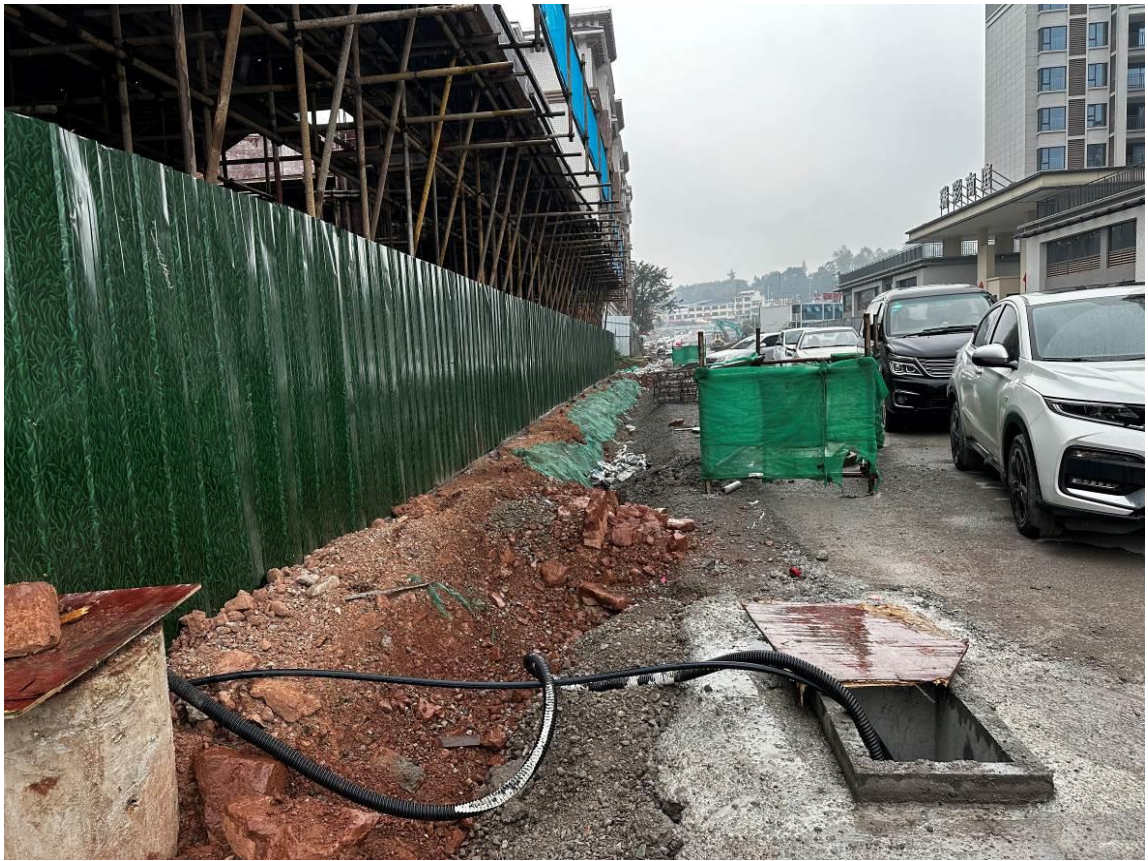
永久排水工程基槽区域，现状临时排水
