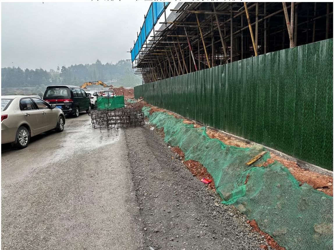
项目区中段临时遮盖
