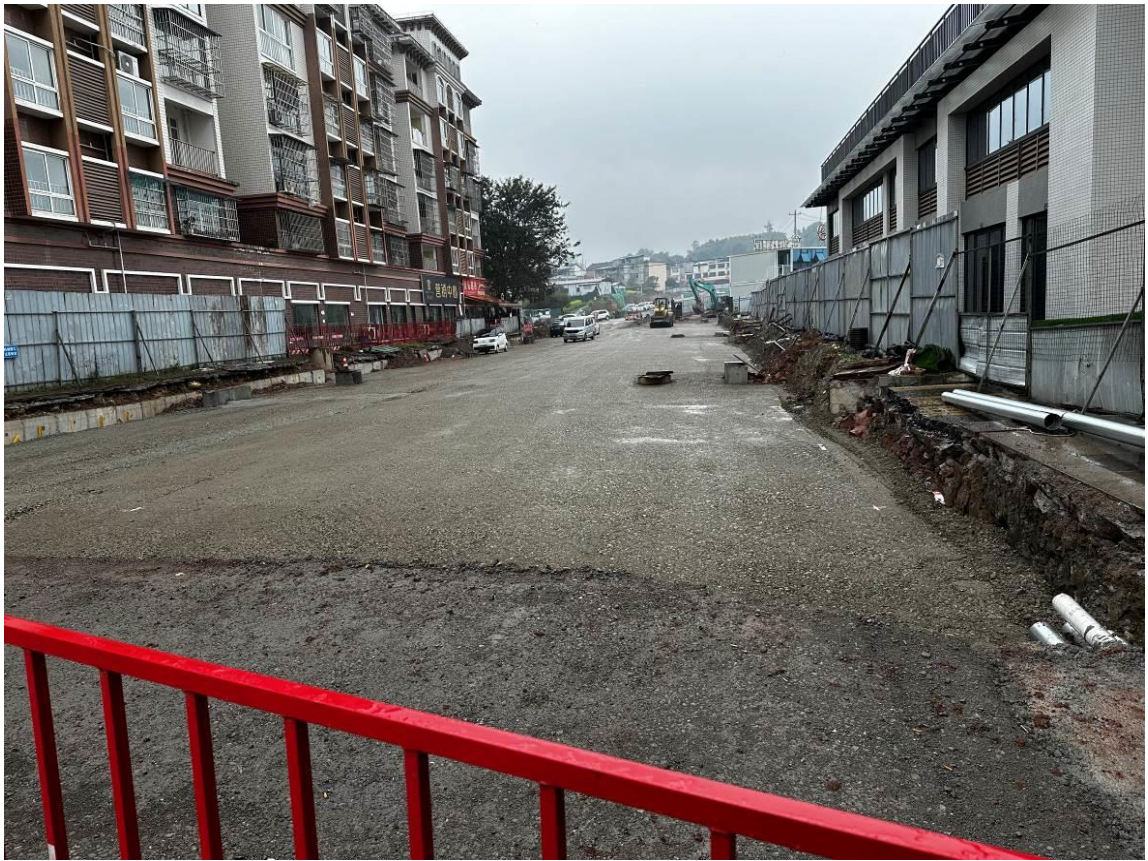
项目区现状路基区域情况（图中为中段向起点方向拍摄）
